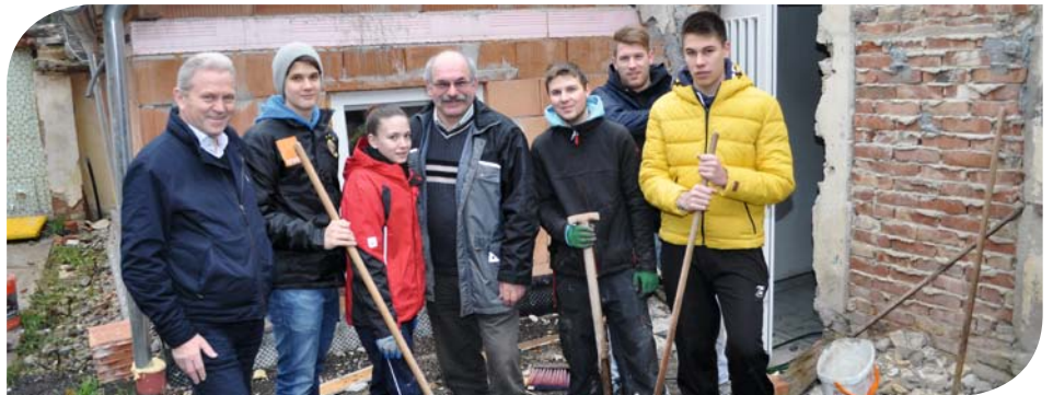
Bürgermeister Hubert Meisl und Ortsvorsteher Stadtrat Franz Parth bei der Besichtigung der Baustelle im Jugendheim Gobelsburg.
