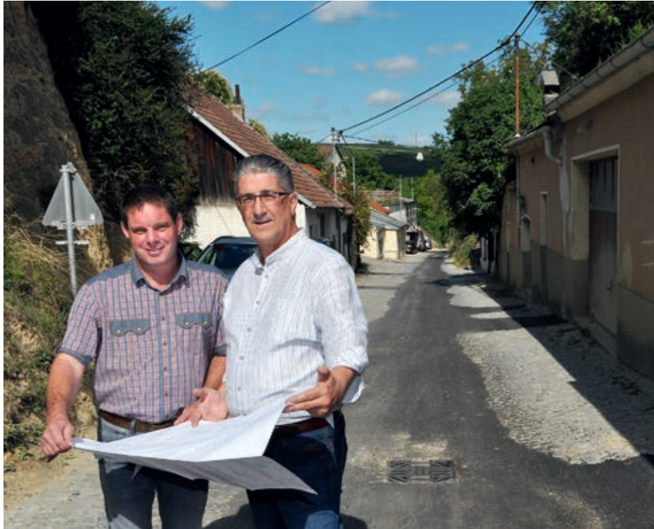
Kanal- und Wasserleitungsbau im Buriweg
