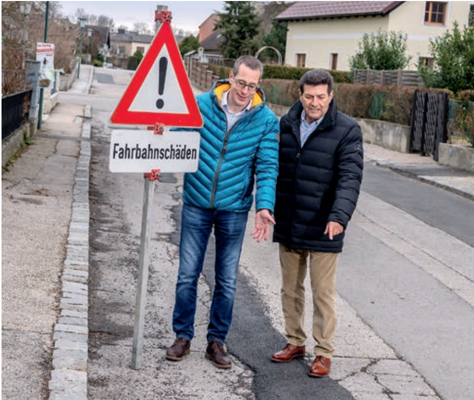
Generalsanierung der Anton Zöhrer-Straße
